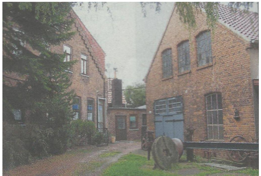
Das alte Rotsteingebäude an der alten Hauptstraße (Westseite des Kirchweyher Bahnhofs)
